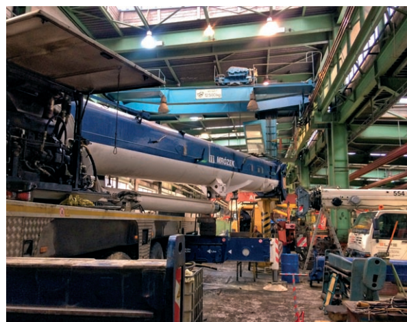
Naprawy żurawi to z jednej strony „hardware” wymagający zastosowania suwnicy, ale także „software” układów elektronicznych i automatyki obsługiwanych komputerem diagnostycznym
